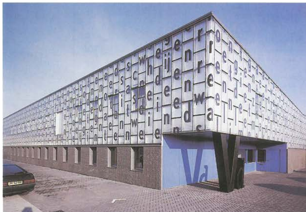
18.9. ábra. Veenmann Nyomda – Ede/Hollandia 1995–1997 (Neutelings-Riedijk; Willem Jan Neutelings, Michel Riedijk). A kis nyomdaüzemet jellegzetes transzparens hőszigetelésű homlokzata, egyszerű szerkesztése, barátságos belső terei emelik a jó példák közé.
