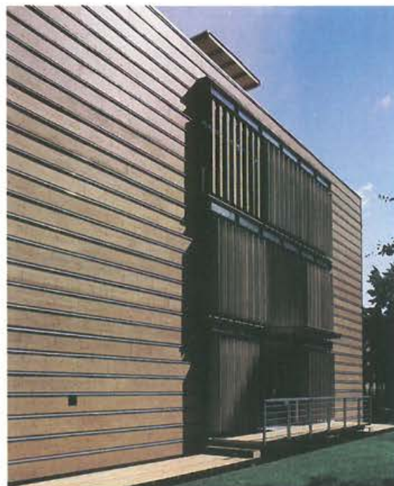
18.26. ábra. Lowe-GGK irodaház-bővítés – Budapest, 1997–1998 (Kovács István, Tér 64 Stúdió). Karakteres szecessziós villa bővítése ez a „tárgyszerű” épület. Szerkezetei, burkolatai is igen gondosan választottak, korszerűek. Kivitelező: Arcadom Rt. Fotó: Häider Andrea.
