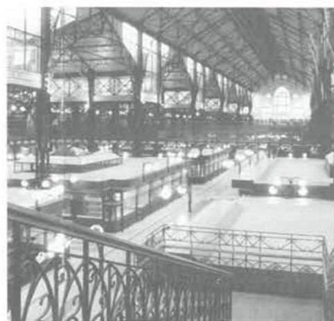
14.31. ábra. A megújult csarnok belső képe.
