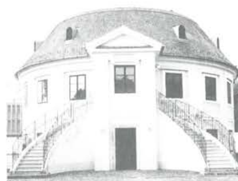
14.33. ábra. Az Óbudai Selyemgombolyító új főhomlokzata.
