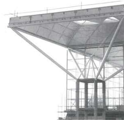
5.1. ábra. A Stantsteed repülőtér (N. Forster, 1981–1991).
