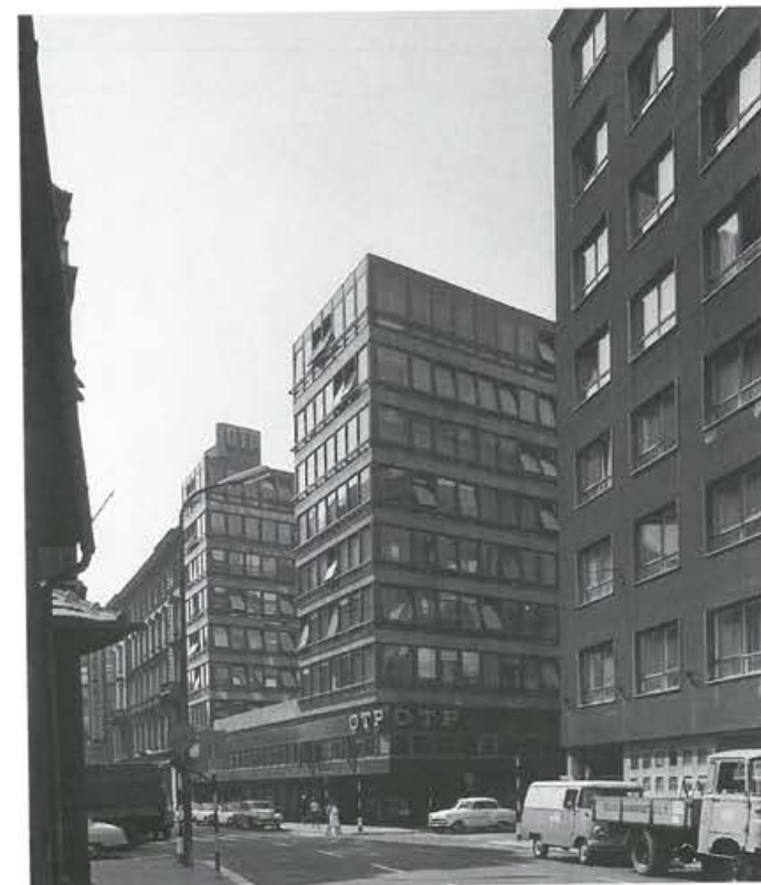
18.23. ábra. Az egykori Chemolimpex, most OTP-székház – Budapest, 1963 (Gulyás Zoltán, Iparterv) Az 1960-as évek hazai irodaépítészetének legjobbja. A belvárosi saroktelek elegáns beépítése.
