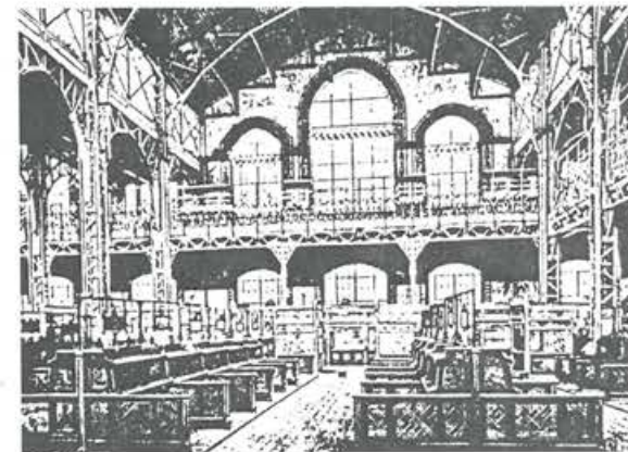
14.26. ábra. Az eredeti csarnok belső képe.
