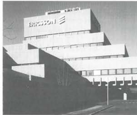
14.15. ábra. Az új főhomlokzat.
