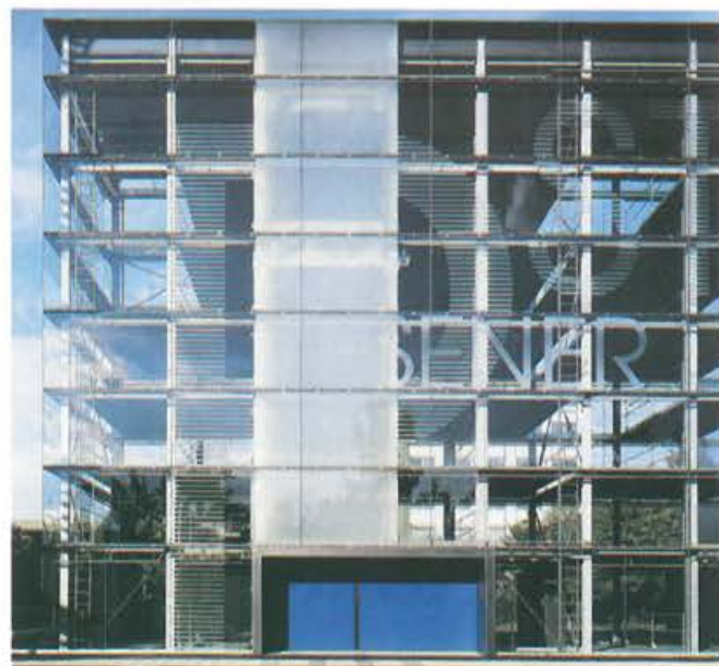
18.41. ábra. Automata parkolóház – Sindelfingen/Németország, 1999 (Petry+Wittfoht Architecten). A 124 gépkocsi tárolására alkalmas „polcrendszer” szép üvegfelülettel illeszkedik a környezetbe.
