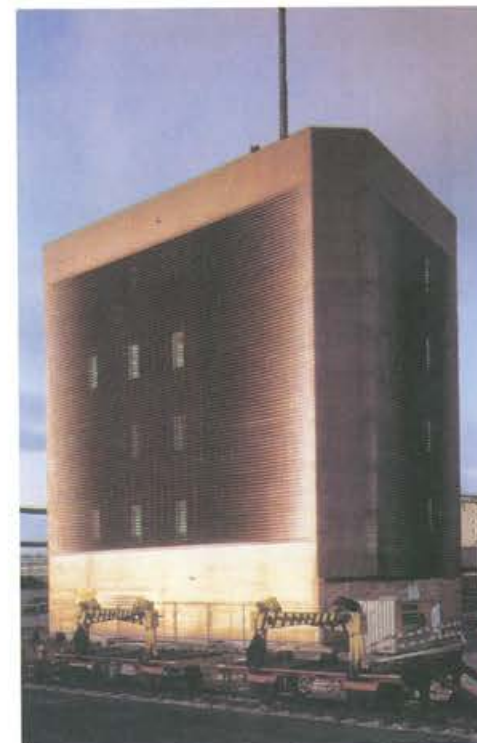
18.36. ábra. Vasúti irányítóépület – Bazel/Svájc, 1989 (Herzog & de Meuron). Az egyszerű épület különlegességét a rézlemezcsíkokból készült borítás adja. A megvilágítási igényeknek megfelelően ezek kifordulnak, vagy egymás mellé sorolódnak, a homlokzatnak egyszerre monumentalitást és játékosságot biztosítva.
