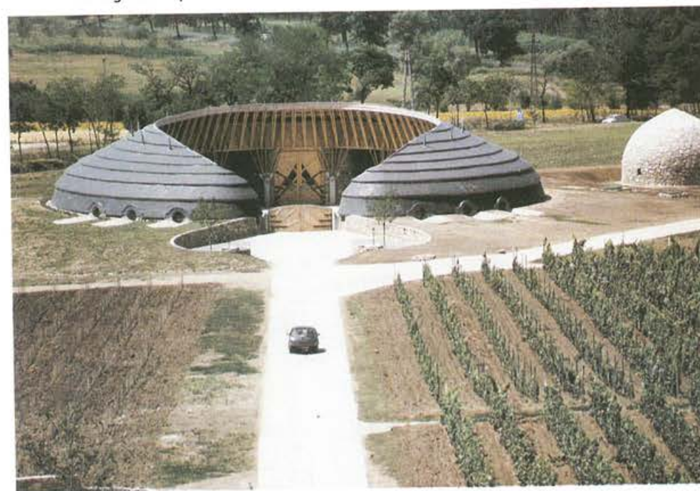
18.20. ábra. A Disznókő Rt. borüzeme – Mezőzombor/Magyarország, 1995 (Ekler Dezső). Az organikus építészet eszközei az ipari építészeti feledat kitűnő megoldásaként.
