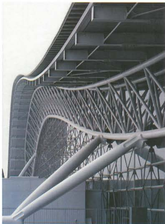
18.40. ábra. Kansai Nemzetközi Repülőtér Oszaka /Japán, 1994 (Renzo Piano és Noriaki Okabe). Az oszakai öbölben létesített mesterséges szigetre épült a lineáris elrendezésű felvételi épület. A lefedés rácsos acélszerkezete hullámos felületet képez.
