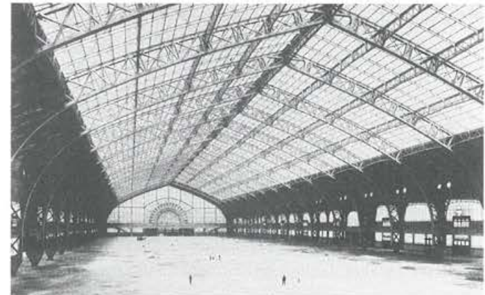
1.10. ábra. Párizsi Világkiállítás, gépcsarnok, 1889 (építész: Charles Dufert, mérnök: V. Contamin).
